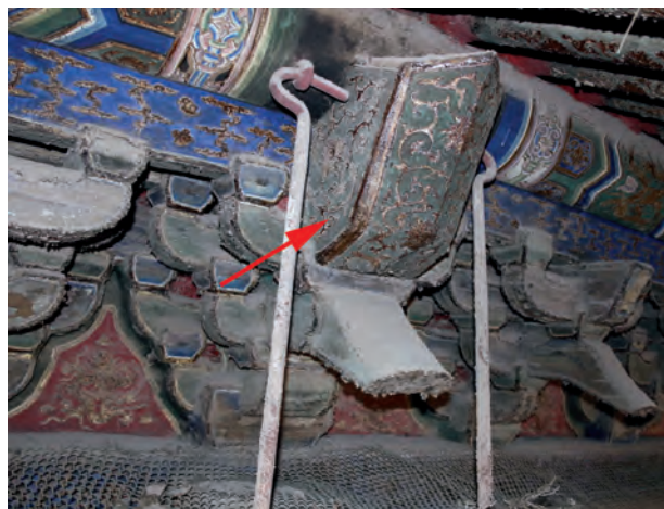
图46 养心殿柱头科——挑尖梁头
