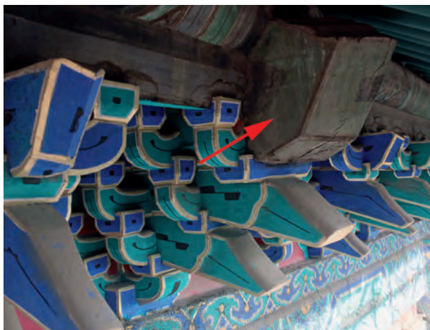
图45 奉先殿柱头科——挑尖梁头
