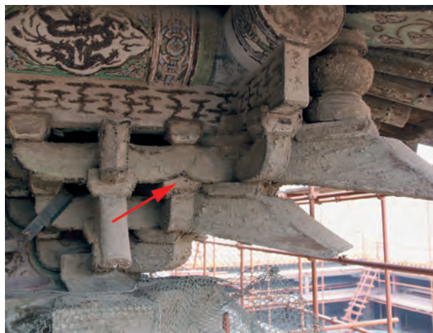
图48 养心殿角科——鸳鸯交首拱
