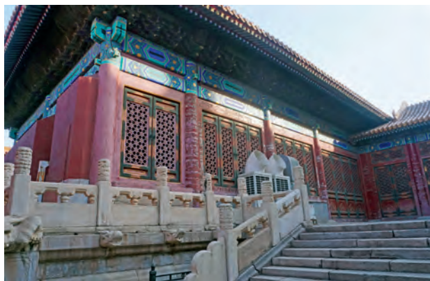
图4 奉先殿后殿及工字廊
