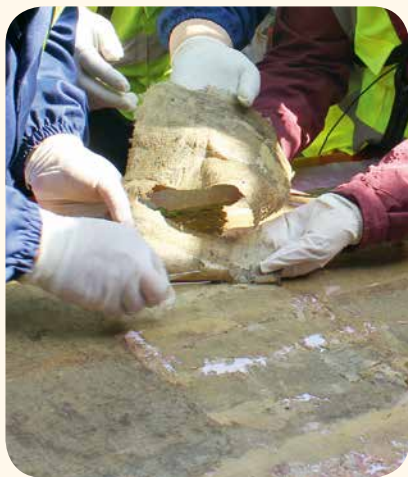
工作人员正在揭取长春书屋顶棚壁布
