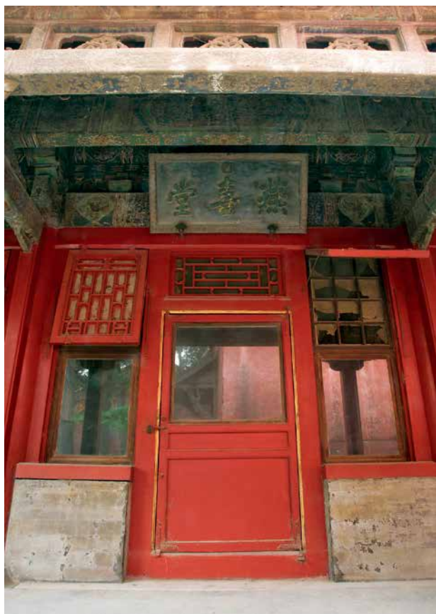
养心殿燕喜堂外景
