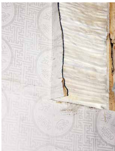
随安室裱糊纸张裂缝处撒鱼鳞修复（裱糊纸张修复的一种方式，纸张呈鱼鳞状排列）
