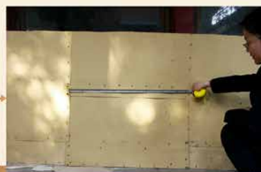
13. 裱糊底层纸，硬纸复合后从后檐墙揭取下来，可见其钉在后檐上
