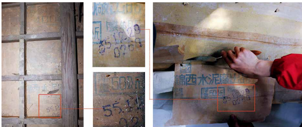
燕喜堂东次间后檐墙揭取下的牛皮纸上可见蓝字「锦西水泥厂出品」、水泥的「试样编号」以及日期「55.12.29」
