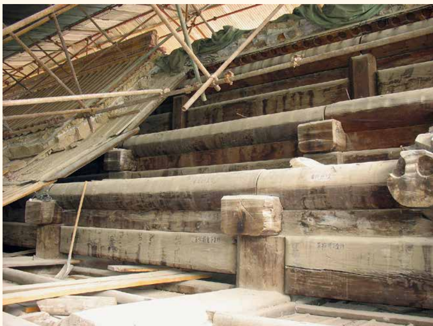
咸若馆大木瓦顶可见木作、瓦作工艺
