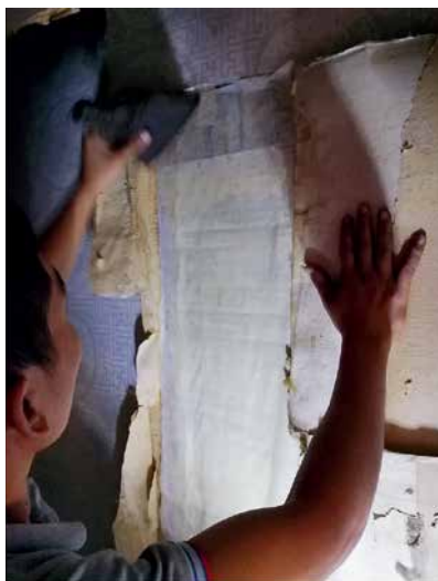
裂缝处鱼鳞纸条上盖一层纸后用棕刷拍实
