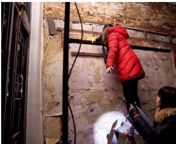
燕喜堂裱糊实验现场勘测
