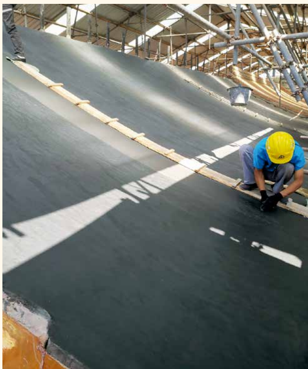
养心殿西夹道围房屋面青灰背压实
