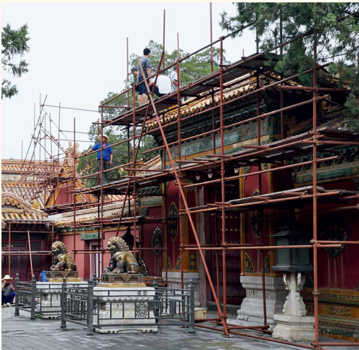
养心门脚手架搭建
