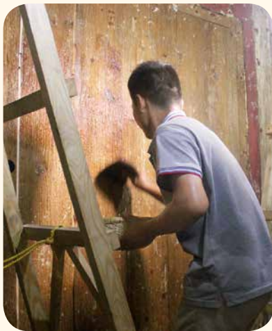
养心殿燕喜堂西梢间后室后檐墙揉浆
