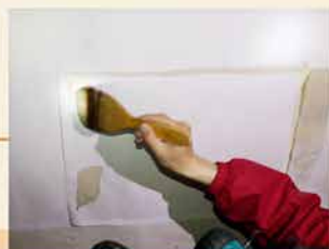
6. 纸张粘接比较牢固的部位用毛刷轻轻浸湿
